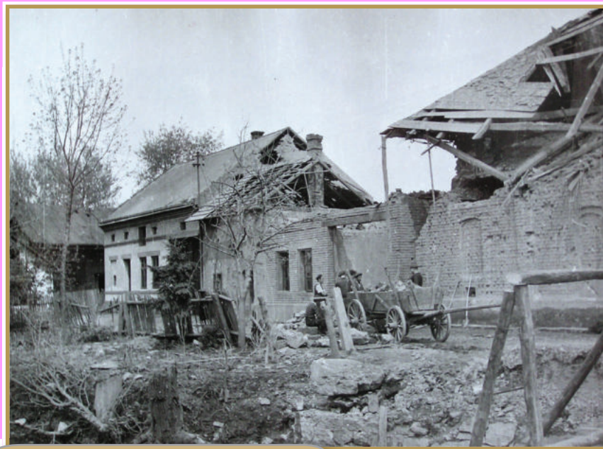
Důsledky německého odstřelu mostu přes Říku.
